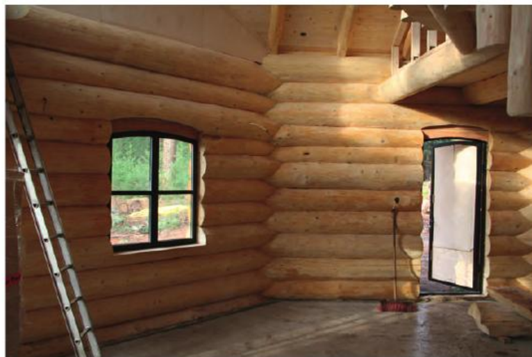
▲ De binnenschil van de boomstamwoningen wordt over 1,5 jaar geschilderd, als alle vochttransport er zo goed als uit is.
