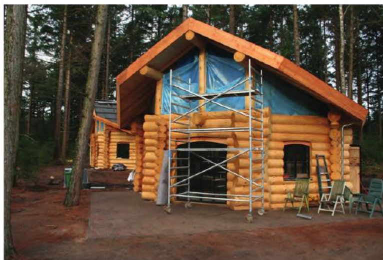
▲ Op de buitenschil werd Treolje V aangebracht. "Het lijkt nu alsof het hout onbehandeld is en dat was ook de bedoeling", aldus Bosscher.
