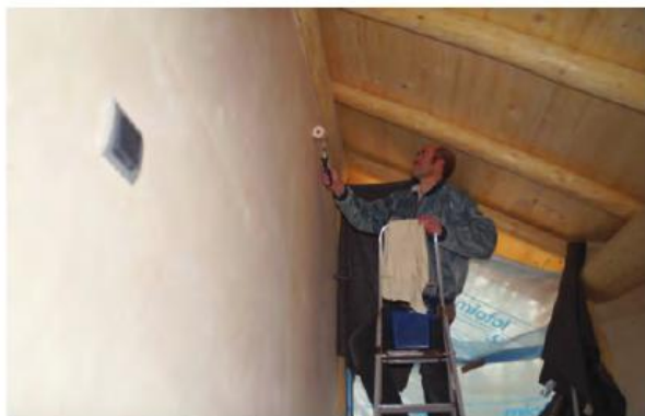
▲ Een tussenwand wordt door een van de schilders in de Trae Lyx Naturel gezet.
